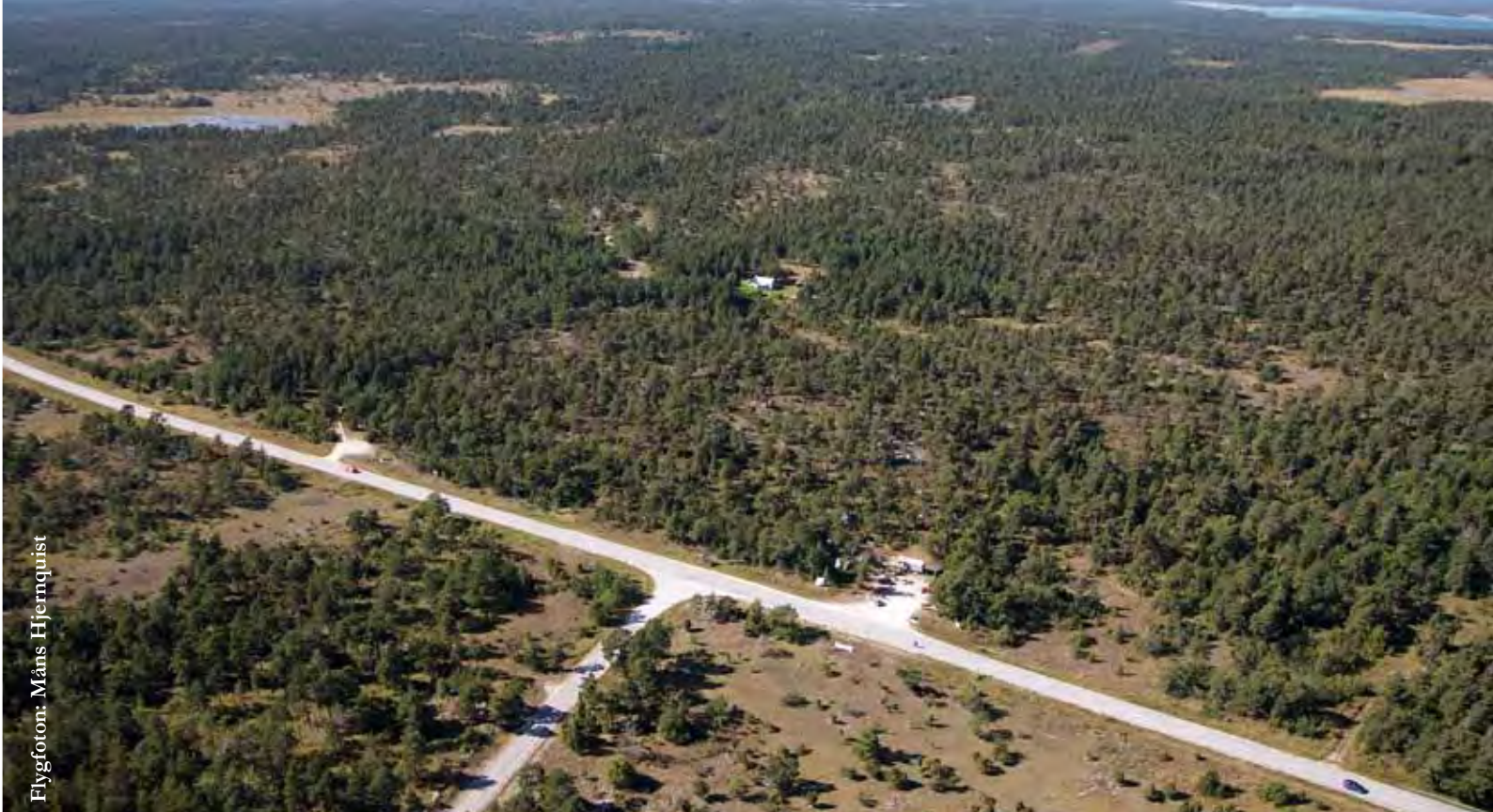
Färösundsvägen med Fältbiologernas tällägrat i Bunn, på Naturvårdsverkets mark, sommaren 2012. I fjärran till höger Ojnare myr och Bäste träsk. Den planerade täkten kommer att ligga till vänster om Ojnare myr och sträcka sig nästan fram till Färösundsvägen.
